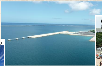
新たなクルーズ船用岸壁(新港心頭地区)
